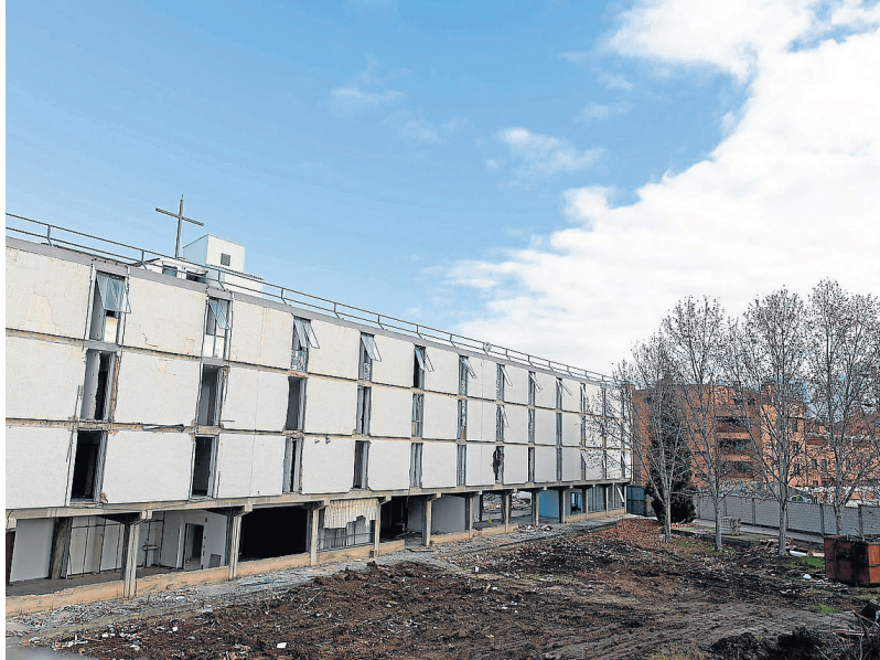
Las obras de derribo del convento de Santa Inés se paralizaron a mediados de diciembre. FRANCISCO JIMÉNEZ
